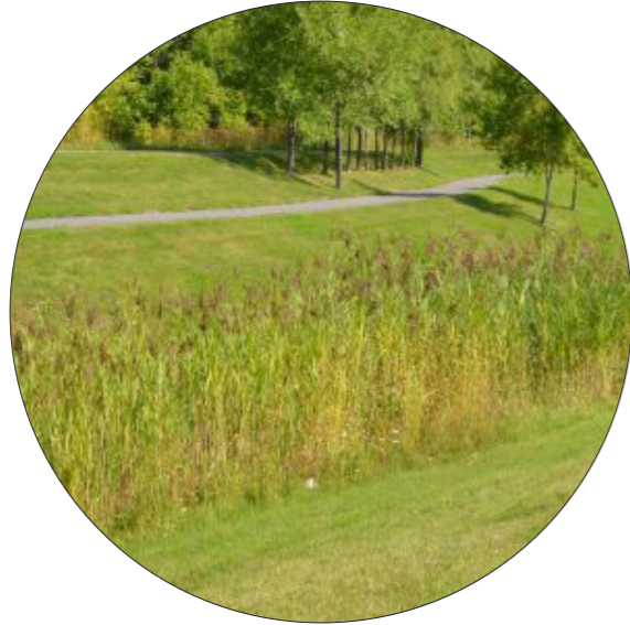
BASSIN DE RÉTENTION
