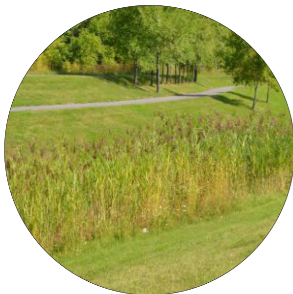
BASSIN DE RÉTENTION
