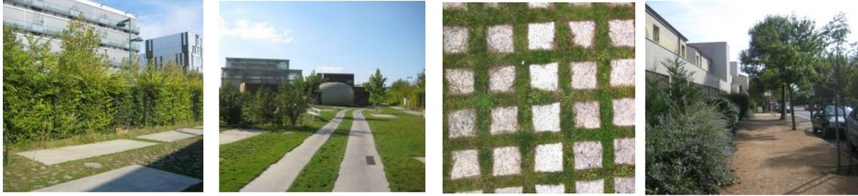
*Exemples illustratifs : graviers, dalle sur pelouse, stabilisé ou terre armée, pavés drainant ou à joints engazonnés, bande de roulement.*
