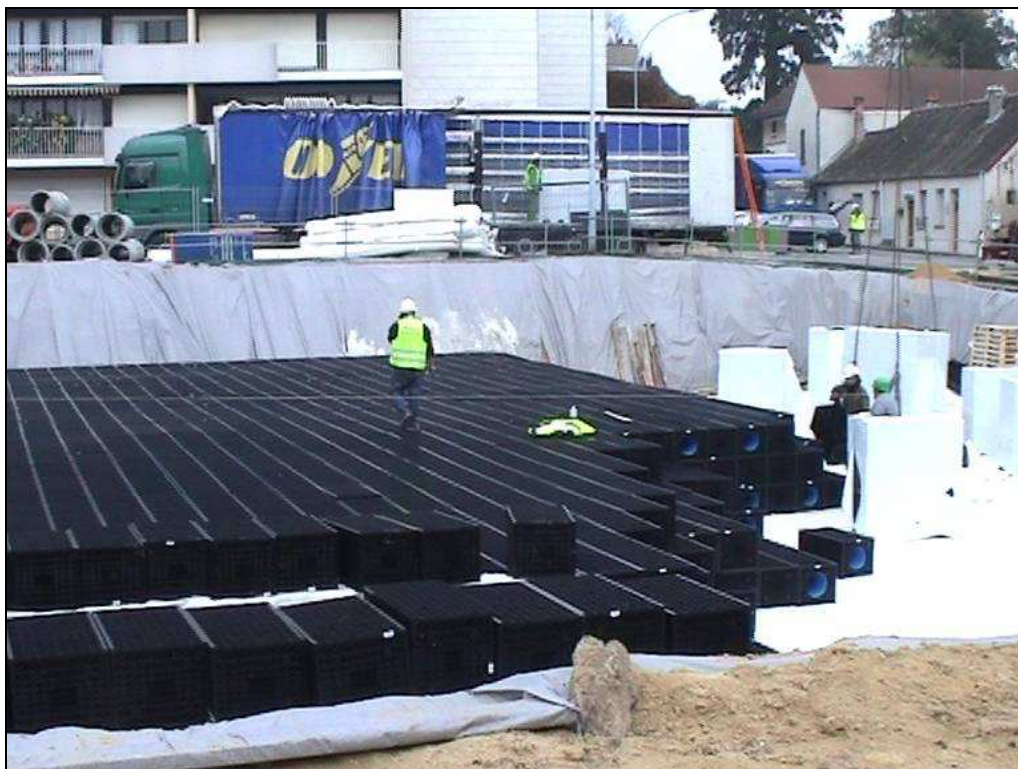
Photo n° 8 : structure en casier d'un bassin à Crosne (91) – source photo : Prolog Ingénierie
