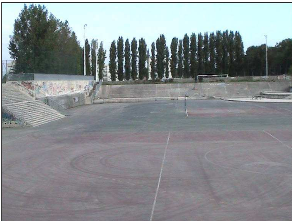
Photo n° 3 : bassin sec revêtu multi-usages, alimentation du bassin de Clichy-sous-Bois (93) – source photo : Prolog Ingénierie
