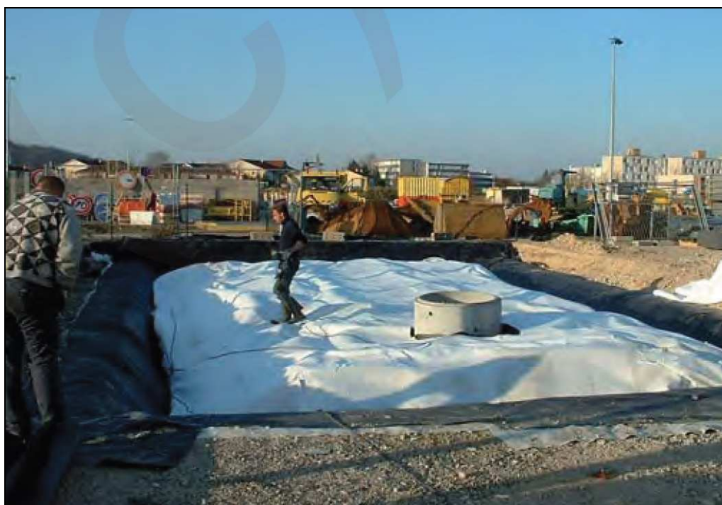
Photo n° 10 : structure en pneu recyclés (source : photo : Aliapur, Sleg, Brunet TP)
