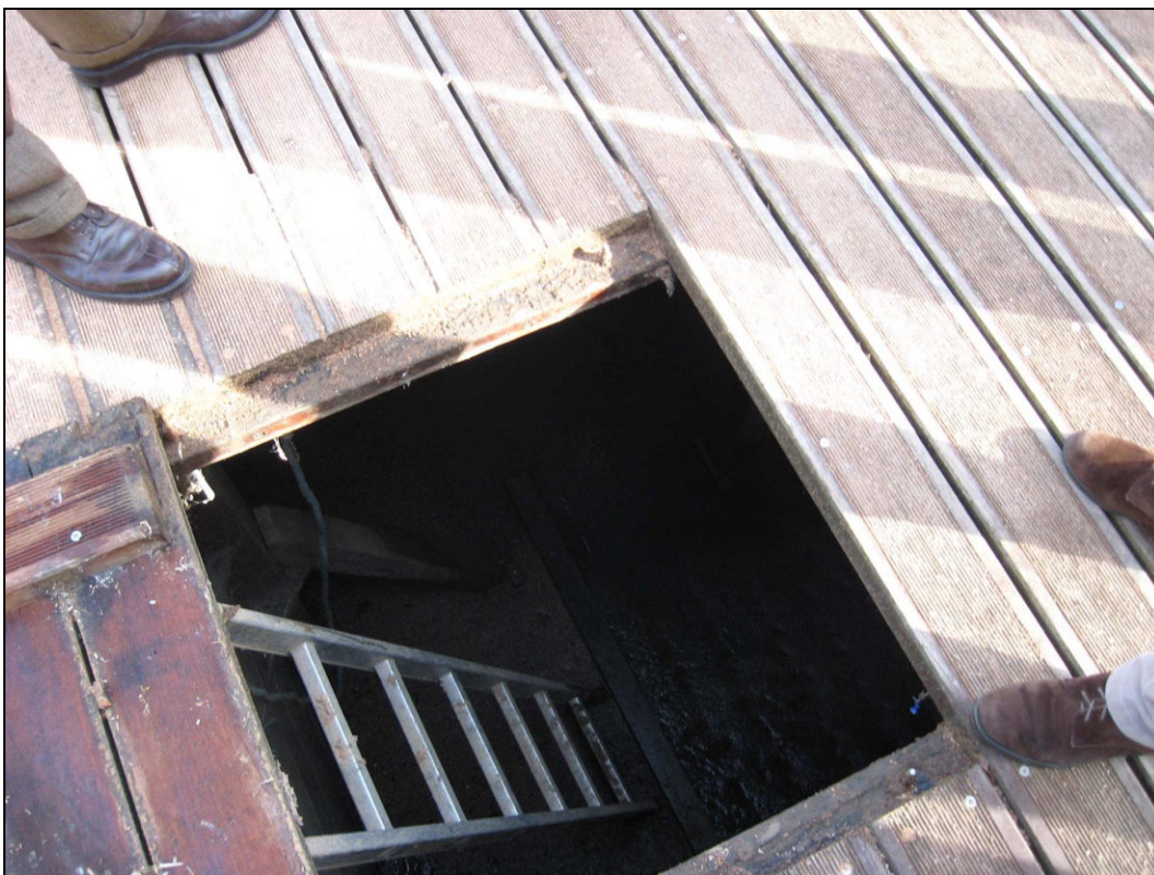
Photo n° 6 : bassin enterré sous un jardin public à Chatillon (92), accès au bassin – source photo : Prolog Ingénierie
