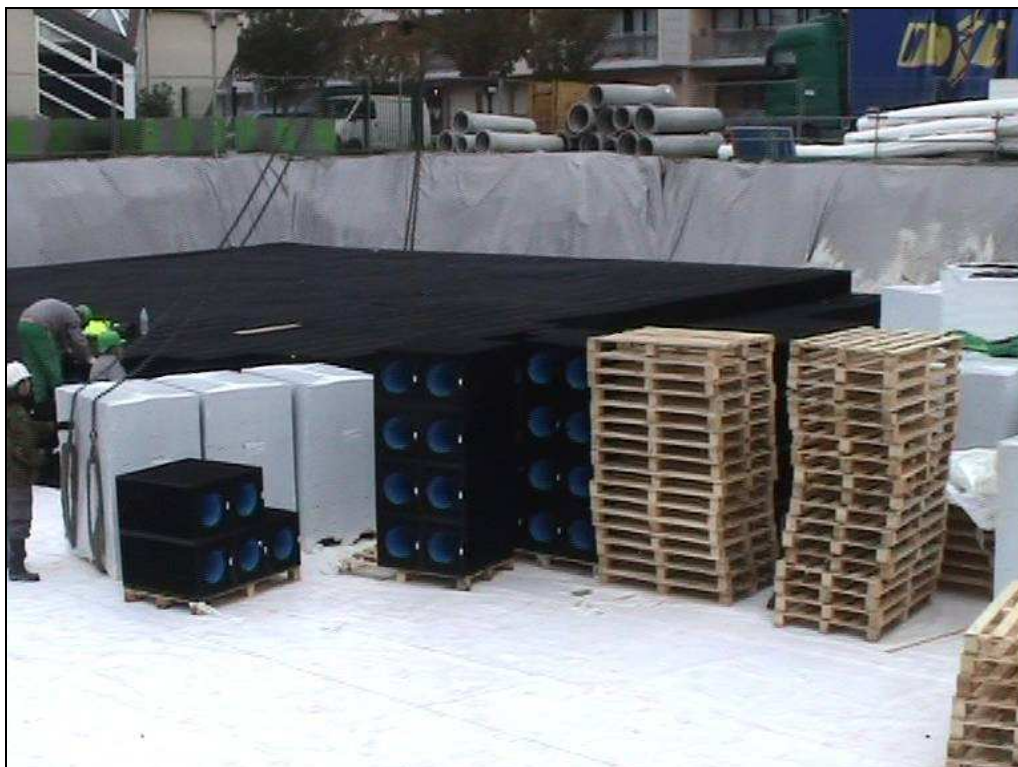
Photo n° 8 : structure en casier d'un bassin à Crosne (91) – source photo : Prolog Ingénierie
