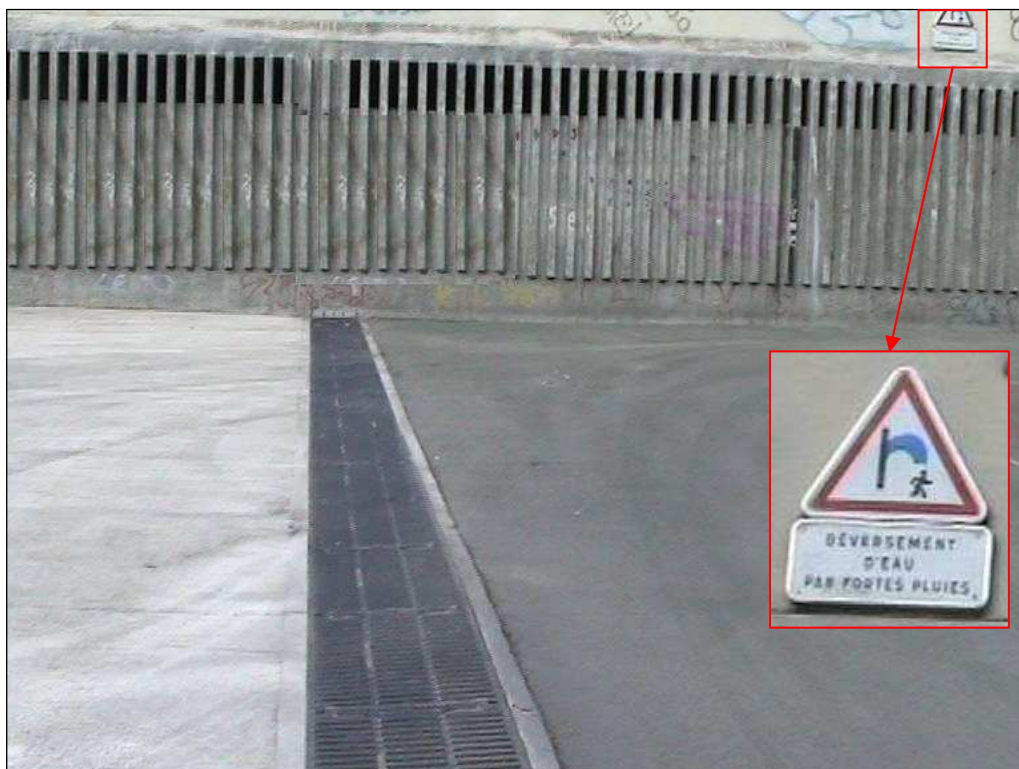
Photo n° 3 : bassin sec revêtu multi-usages, alimentation du bassin de Clichy-sous-Bois (93) – source photo : Prolog Ingénierie
