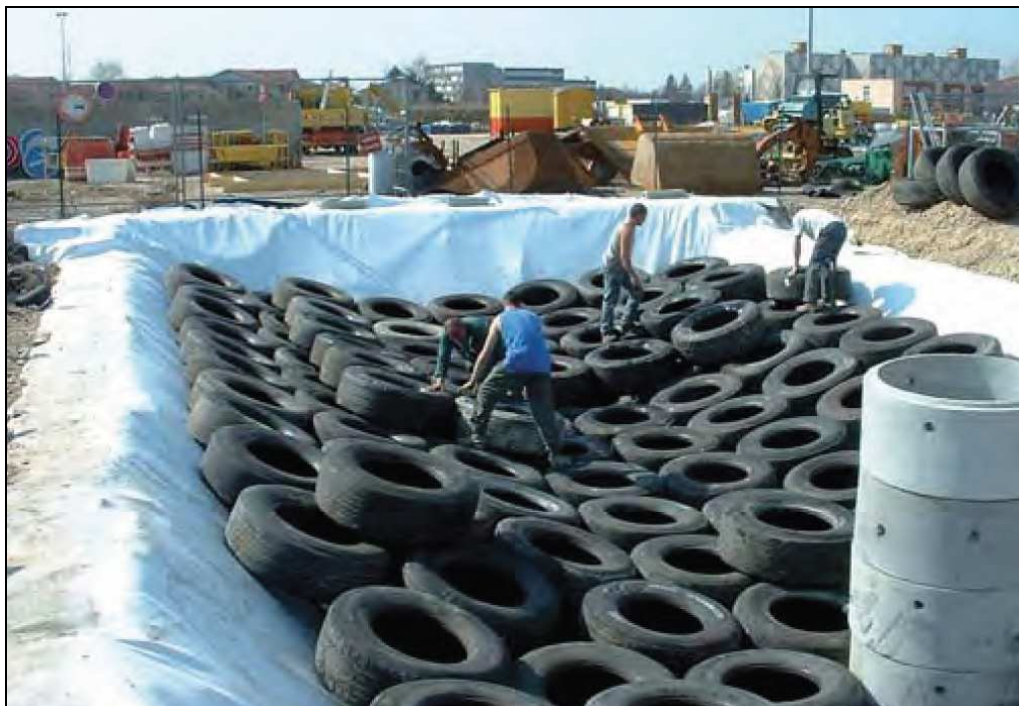
Photo n° 10 : structure en pneu recyclés (source : photo : Aliapur, Sleg, Brunet TP)
